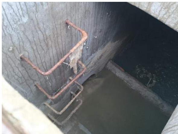
Slika 1.5 Postojeći sustav odvodnje u Garešnici – preljevne građevine
