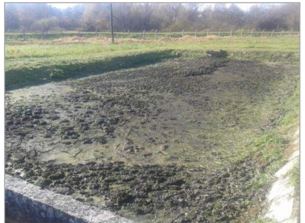
Slika 1.10 Ispust pročišćene vode (lijevo) te polja za sušenje mulja (desno) na UPOV-u Garešnica
