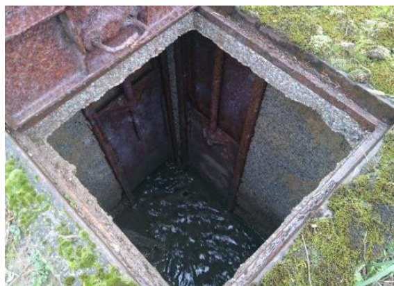
Slika 1.4 Postojeći sustav odvodnje u Garešnici – preljevne građevine
