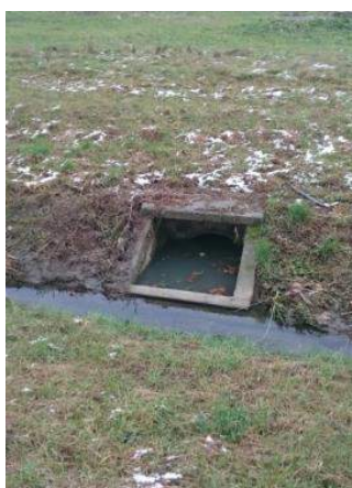
Slika 1.5 Postojeći sustav odvodnje u Garešnici – preljevne građevine
