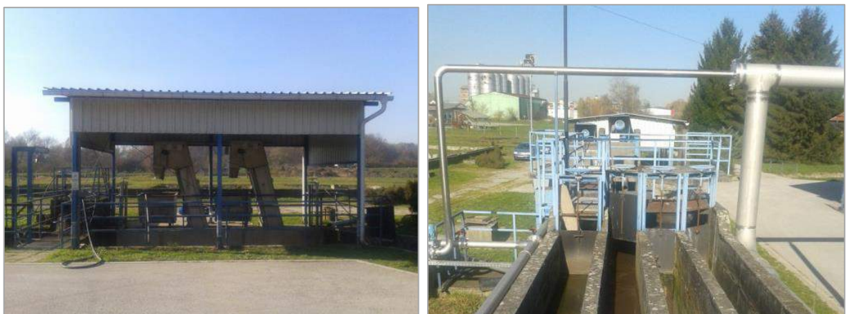
Slika 1.8 Mehanički predtretman na UPOV-u Garešnica: Gruba i fina rešetka (lijevo) te pjeskolov/mastolov (desno)
